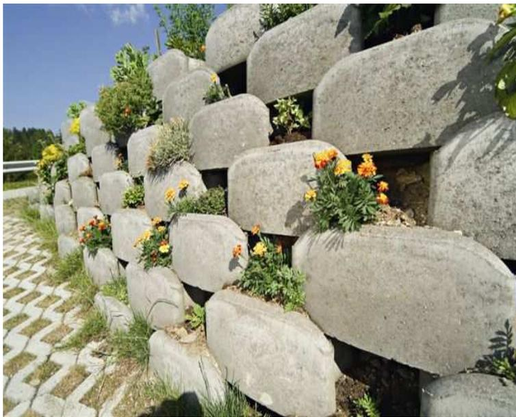
E' possibile utilizzare gli elementi FBK Green Mini per muri con inclinazioni  $25^{\circ} \div 70^{\circ}$ . Il blocco, non essendo dotato di incastro fisso, consente di variare l'inclinazione verticale a piacimento ed adattare il muro alla scarpata esistente. E' possibile creare curve concave e convesse nei limiti descritti a seguire.
