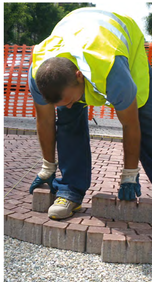
Rapido accesso ai sottoservizi stradali e ripristini senza tracce visibili.
